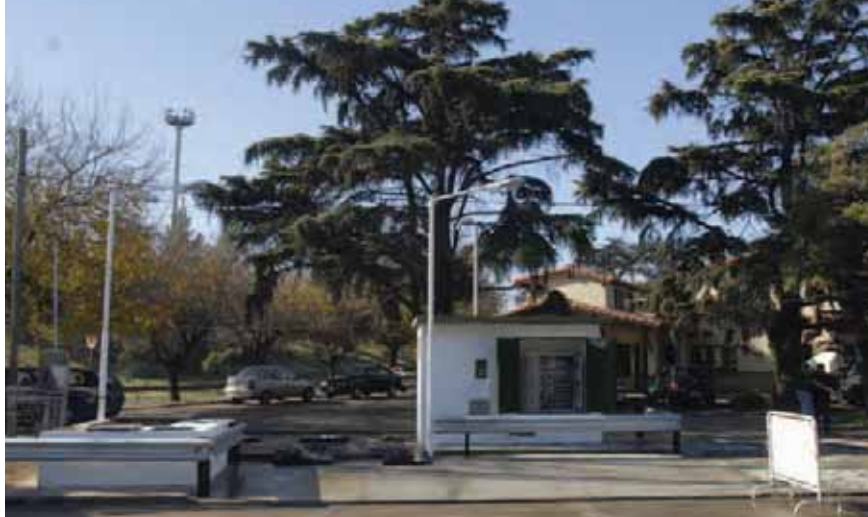
Estación de bombeo cloacal.
