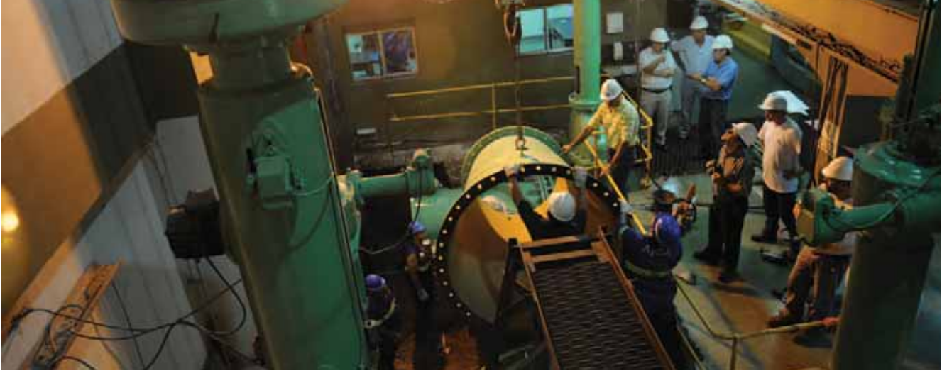
Trabajos en la estación elevadora Devoto.
