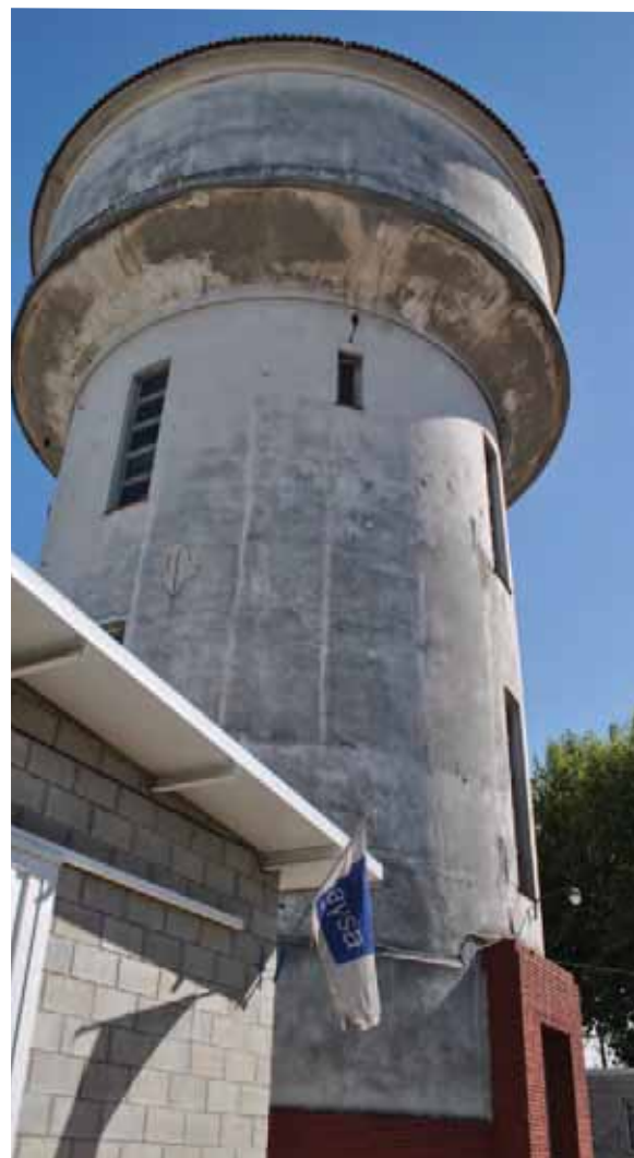
Pozo de bombeo de agua Zona Norte.
