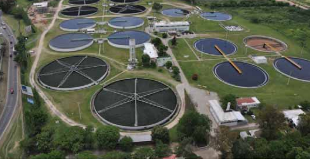
Vista aérea de la planta depuradora Sudoeste
