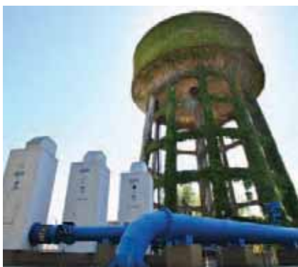
Pozo de bombeo de agua.
