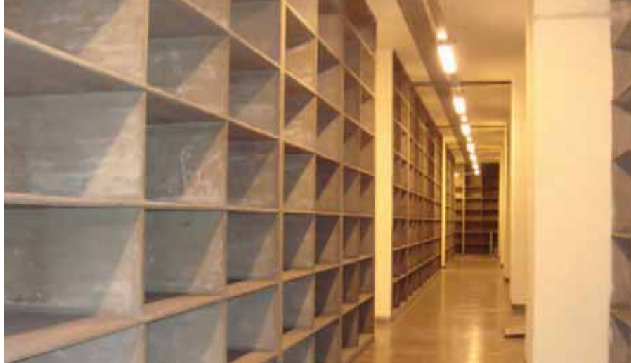
Sector recuperado del primer piso del Palacio de las Aguas Corrientes.
