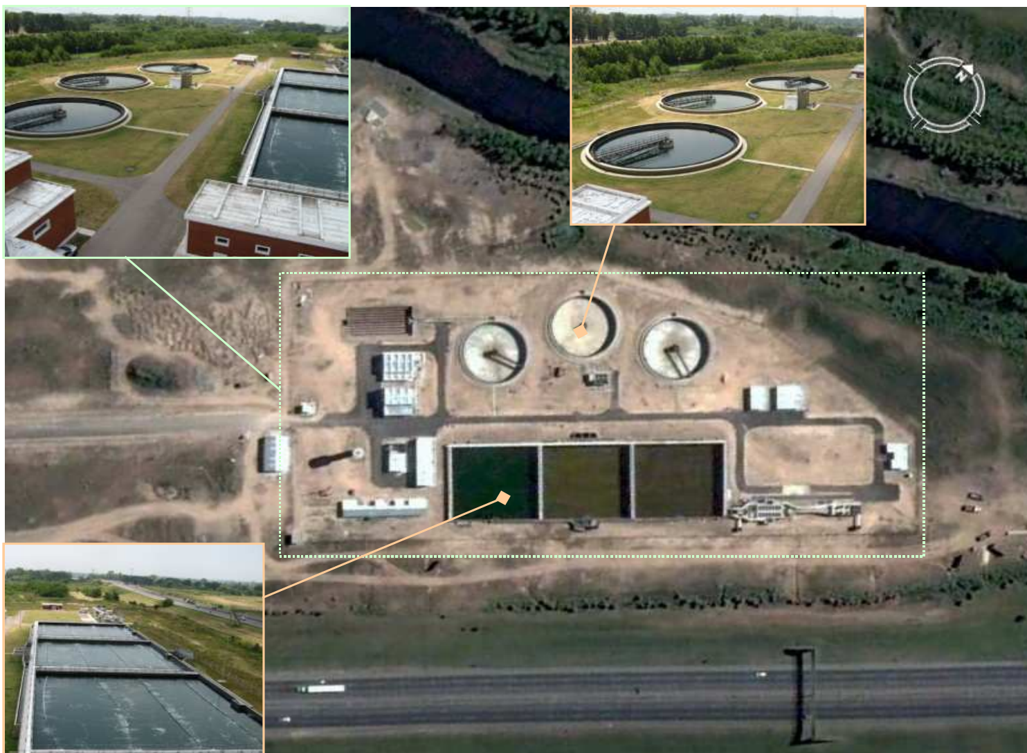
Figura 3: Emplazamiento y situación actual de las instalaciones
