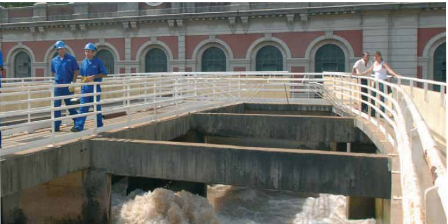
Cámara de carga de la planta potabilizadora Gral. San Martín.
