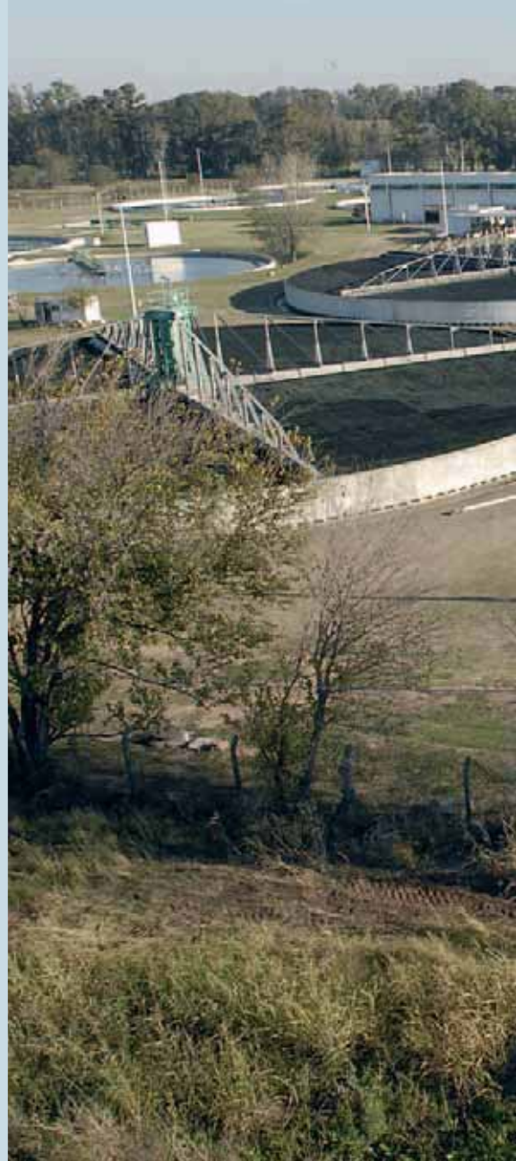
Planta depuradora Sudoeste.
